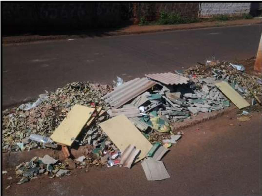
Figura 48 - Acondicionamento inadequado dos RCC nas vias públicas
