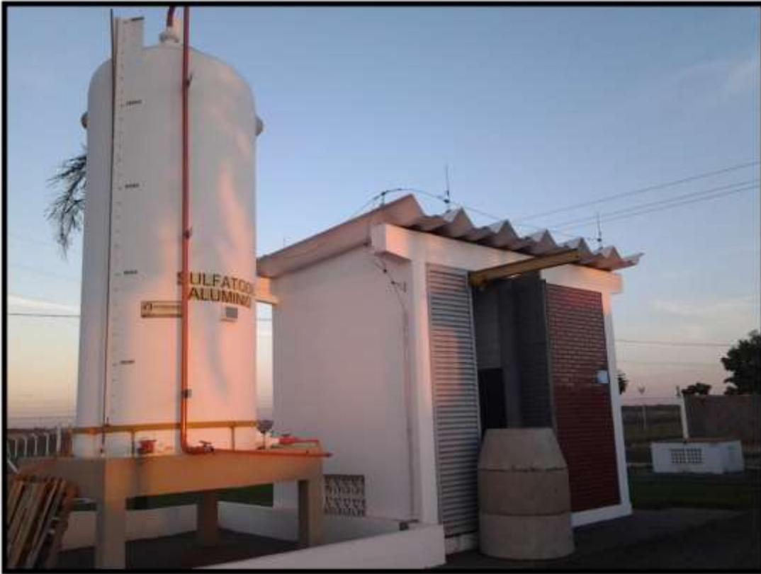
Figura 4 - Adição de Sulfato de Alumínio ETA Avenida 15, 581
