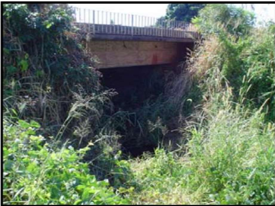
Figura 66 - Presença de vegetação ocupando parte da calha do rio
