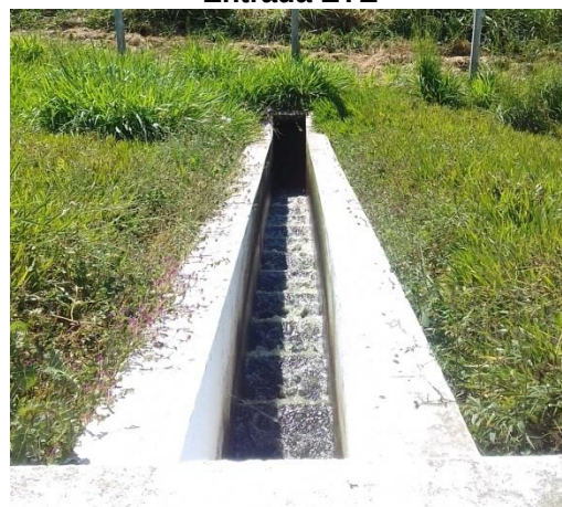
Foto 3.13 – Escada Hidráulica
