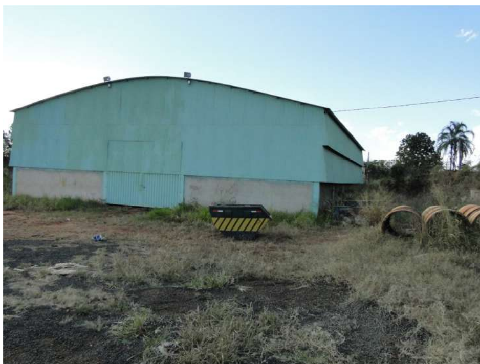
Figura 11. Vista do galpão para triagem de recicláveis e reutilizáveis.
