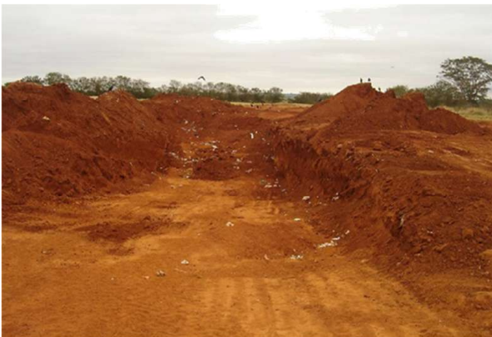
Figura 10. Abertura de vala no aterro licenciado em utilização.
