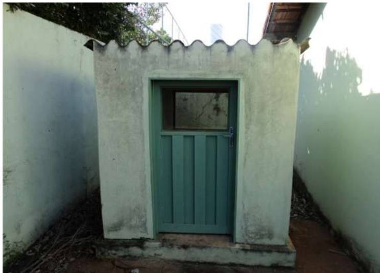
Figura 24 – Vista geral do abrigo de RSS da Santa Casa de Misericórdia de Paulo de Faria Autor: Equipe técnica, 2012.
